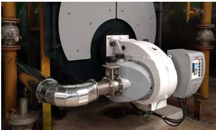
Bruciatore ELCO con sistema FGR installato in Cina in grado di raggiungere livelli di emissioni NOx inferiori a 30 mg/kWh
